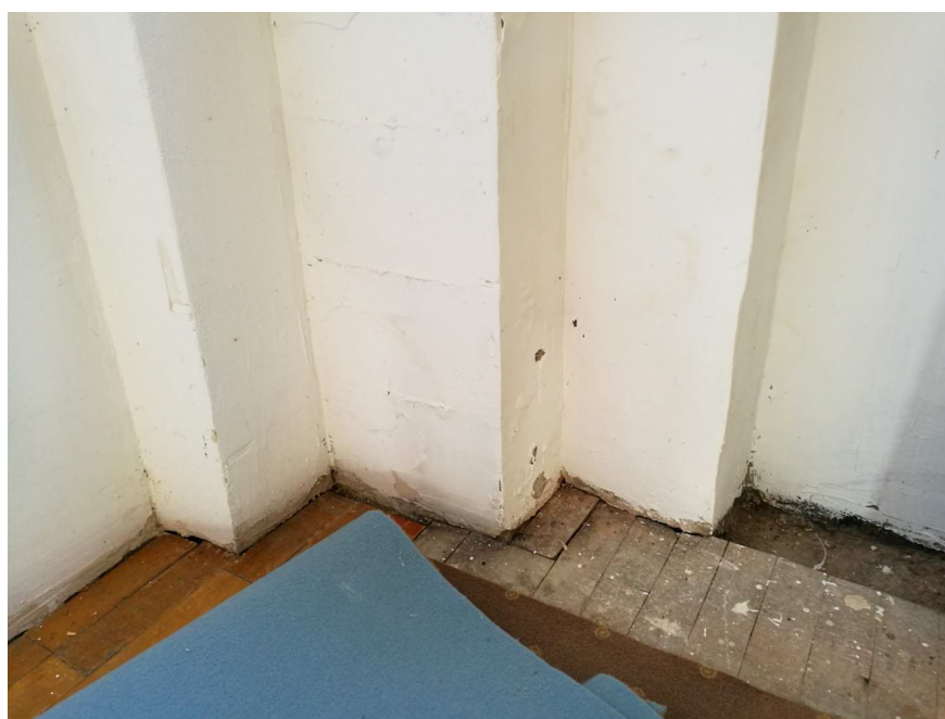
Fot. 6 Zawilgocenie ścian w narożniku (Narutowicza/Kusocińskiego).
