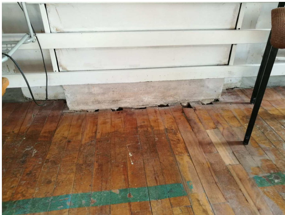
Fot. 5 Zawilgocenie filara międzyokiennego. Widoczne odkształcenia deszczulek parkietu wskutek zawilgocenia.
