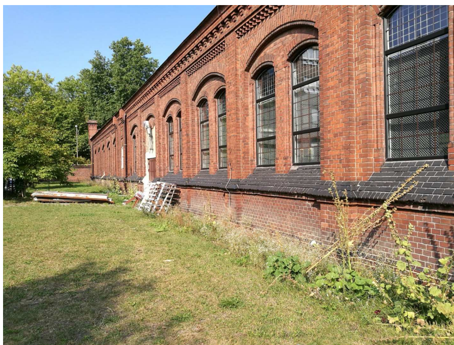
Fot. 4 Ściana południowa. Wzdłuż ściany obniżenie terenu
