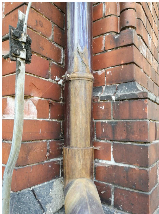
Fot. 3 Nieszczelność rury spustowej. Narożnik Narutowicza/Kusocińskiego
